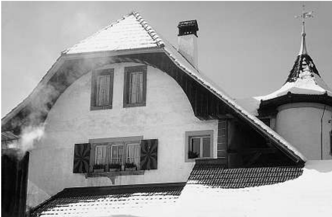
Schlössli Oberdettigen mit Treppenturm, Ostansicht 1988 (Fotoarchiv Wohlen)
