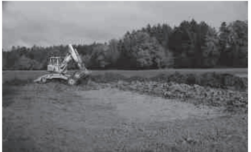
Baggerung Gewässer Moos
