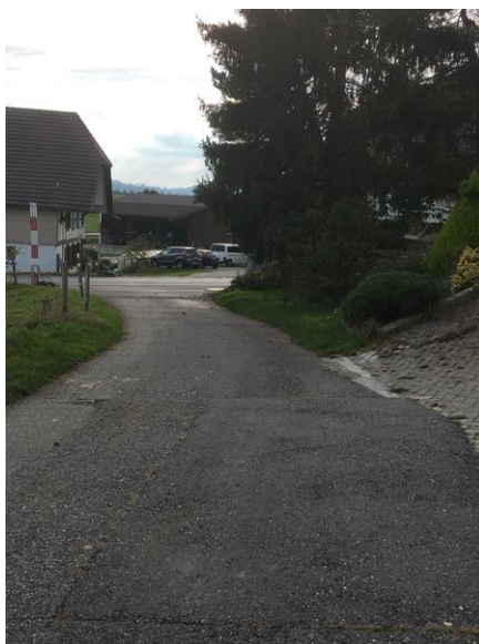
453: Illiswil, Einmündung Kantonsstrasse
